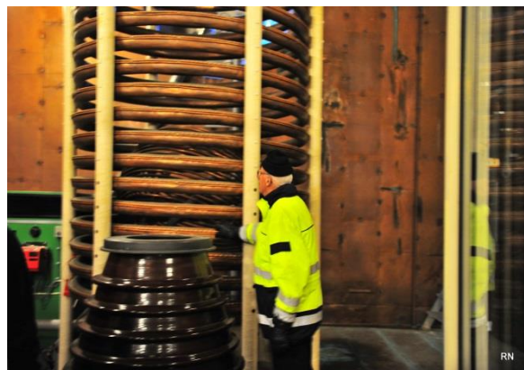
En av sändarens antenninduktanser och en av isolatorerna som sändarmasterna stod på
