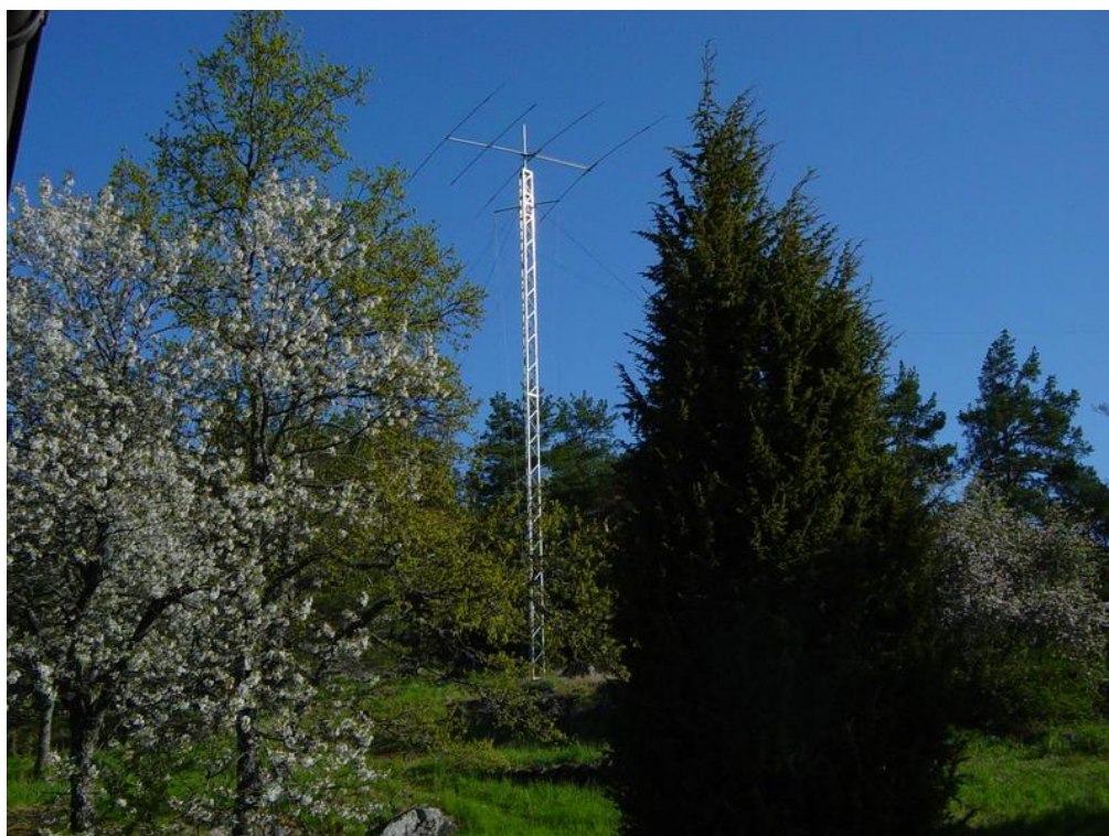
Antennen för 10 i 15 i 20 är en HB34D från japanska företaget TET. Masten är omkring 20 meter över marken. Monterades 1983. För 17, 40 och 80 använder jag en inverterad V och för 160 en dipole.
