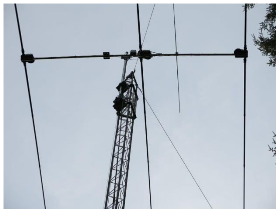
Hazervinschen på plats och antennen har monterats på ett topprör
