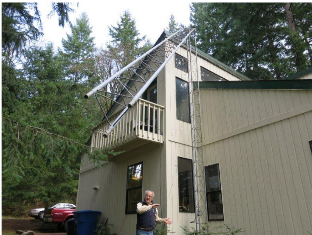
Översta sektionen med antenn och vinsch har demonterats
