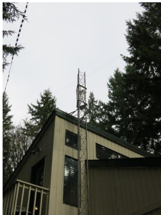
Den nedre delen av masten har rest tillbaka mot huset och väntar på att toppsektionerna ska lyftas på plats.
