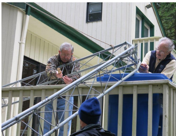
Masten är fälld och skadade sektioner demonteras
