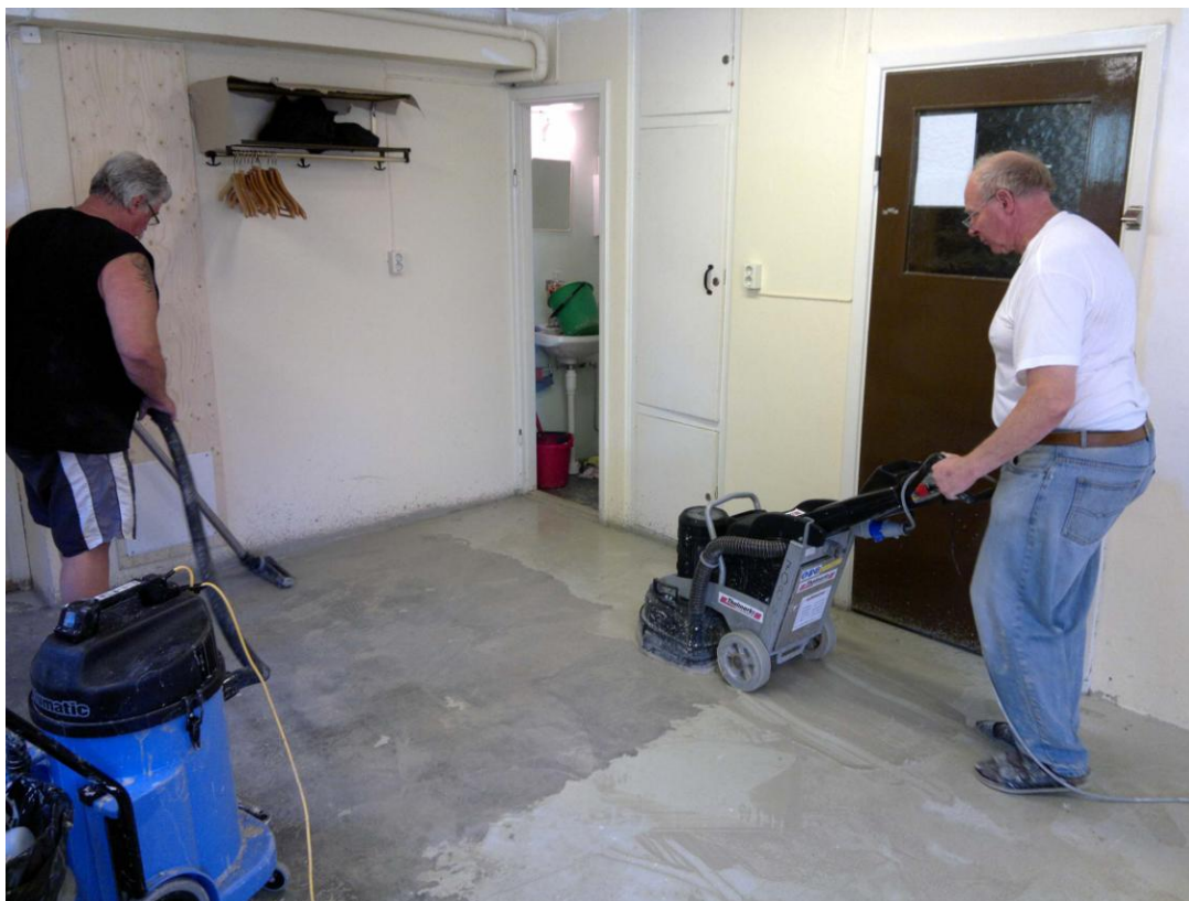
Igge suger upp vatten och färgrester medan Göran slipar
