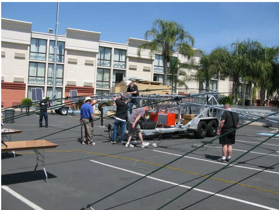
1) Lastvagnen står på parkeringsplatsen och nu visar det sig att vagnen är lastad med mast, antennelement, rotor och kablar.
