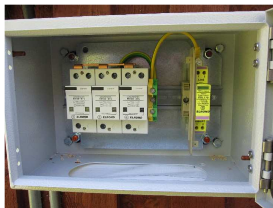
Åskskydden monterade i en låda
