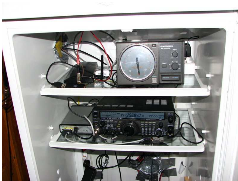
Ett öppnat kylskåp med antennavstämning och antennrotor på övre hyllan. Fjärrstyrustrustning och rigg på hyllan under. Observera genomföringar och håltätning.
