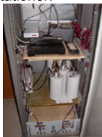
Repeatern med kavitationsfilter
