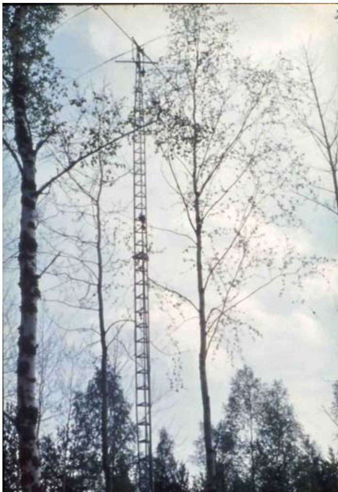
3 elements Yagi för 20-metersbandet.
